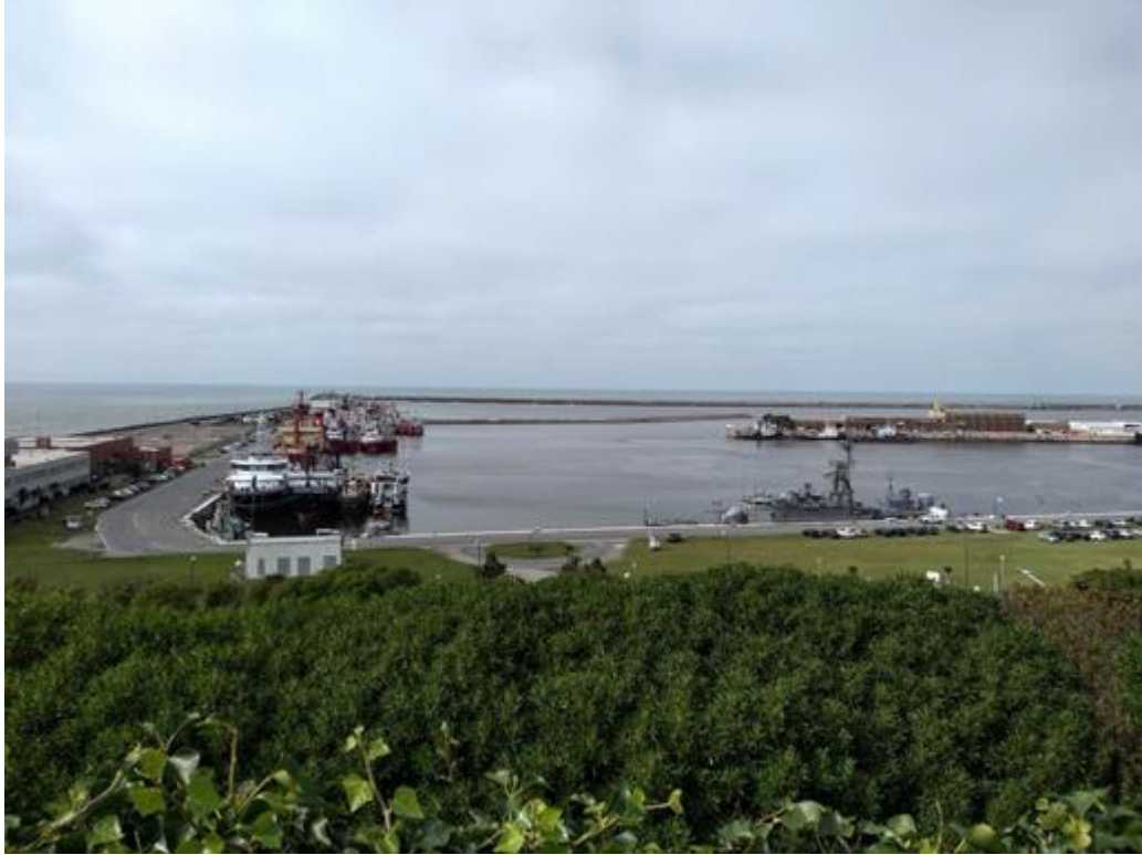
Figura 25: Vista de un sector del Puerto Mar del Plata, con las escolleras norte y sur. Foto: M.M. Pérsico
