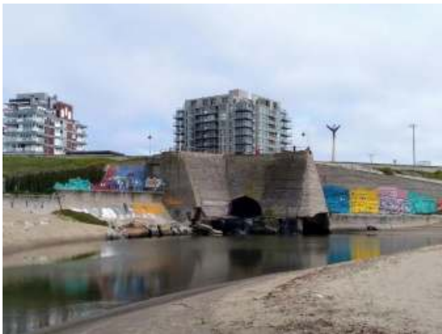
Figura 14: Infraestructura y sitio de descarga de un pluvial en la arena de una playa recreativa ubicada en el sector norte de la ciudad de Mar del Plata. Foto: M.M. Pésico
