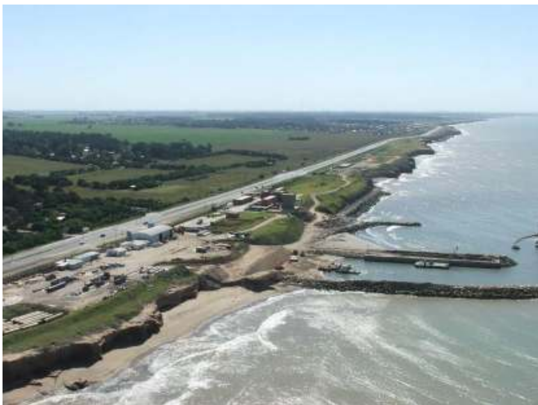
Figura 16: Vista aérea de zona costera donde se ubica la Planta de pretratamiento de los residuos cloacales de la ciudad de Mar del Plata. Foto: A. Saubidet, 2014
